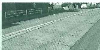
舗装前 道路の舗装
