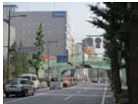
小文字歩道橋
